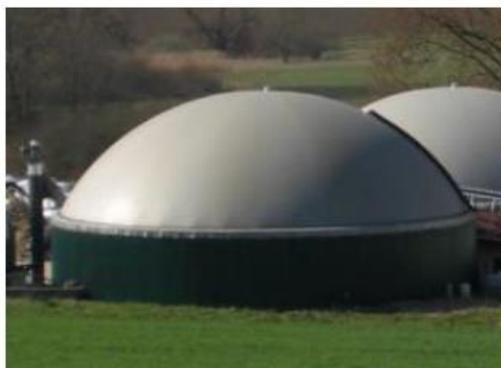
Le stockage du biogaz est prévu grâce à une double membrane fixée sur le post-digesteur. Les équipements permettent de stocker l'équivalent de 6 h de production de biogaz brut. La membrane est maintenue en forme par un ventilateur qui donne la pression de travail requise.
