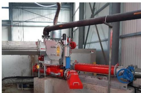
La matière, ainsi préparée, est broyée (système avec piège à cailloux) à la sortie de la pompe broyeuse est envoyée vers le digesteur (5).
